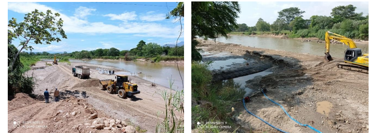
Obras ejecutadas por el Contratista de la ADR en el río Zulia sector Londres frente al salto ICA.
