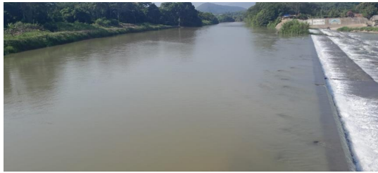
Río Zulia a su llegada a la bocatoma del Distrito, fecha 6 de febrero de 2024.
